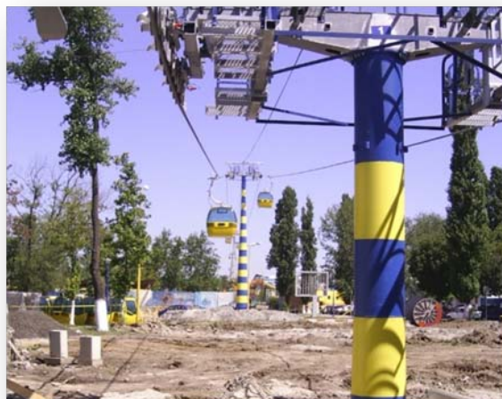
Mamaia: ZINGA 1 x 60 \mu\text{m} DFT PU Topcoat
